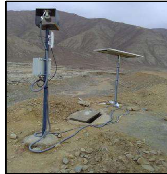
Instalación de estación de monitoreo en la quebrada Huaycoloro
